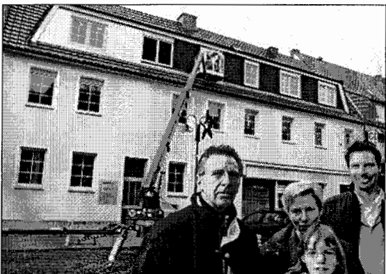
Fassade in Mandarin: Die Eigentümer, Elena John und René Mellin (r.), präsentieren das sonstige Erscheinungsbild ihres Wohn- und Geschäftshauses an der Kämmerstraße 27. Mit dabei: Johns Enkelin Lena Spletter (10) und Dirk Ebbinghaus (l.). ■ Foto: Roman Grzelak
